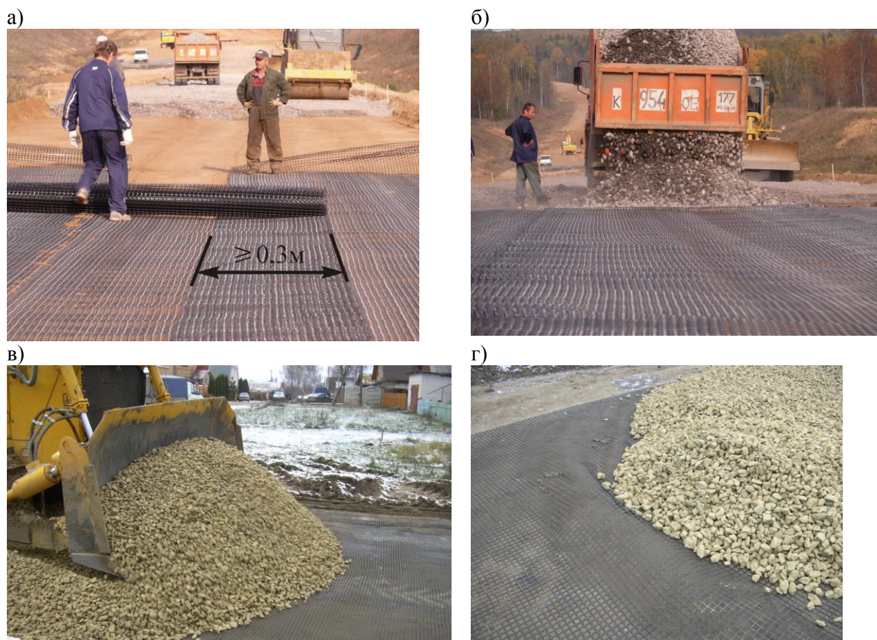
Рисунок 7.2 – Отдельные рабочие операции при армировании дорожных одежд: а – укладка георешетки; б - отсыпка материала несущего основания; в – разравнивание материала по способу «от себя»; г – образование «волны» перед разравниваемым слоем
